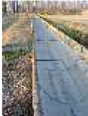
Le canal en béton du Sambuc : un ouvrage à réhabiliter en fonction de besoins à actualiser
